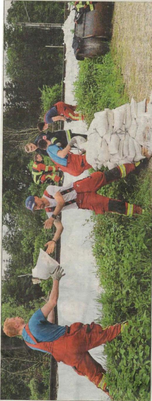
Die Bahntrasse bei Unterreit war am Sonntag kurz nach 13 Uhr für den Zugverkehr gesperrt worden. Einsatzkräfte der Feuerwehr sicherten gegen Mittag den Bahndamm und die Schleusenbrücke am Amper-Überleitungskanal mit Sandsäcken und Folien ab, da weiterhin mit einem deutlichen Anstieg des Amper-Pegels zu rechnen war.
