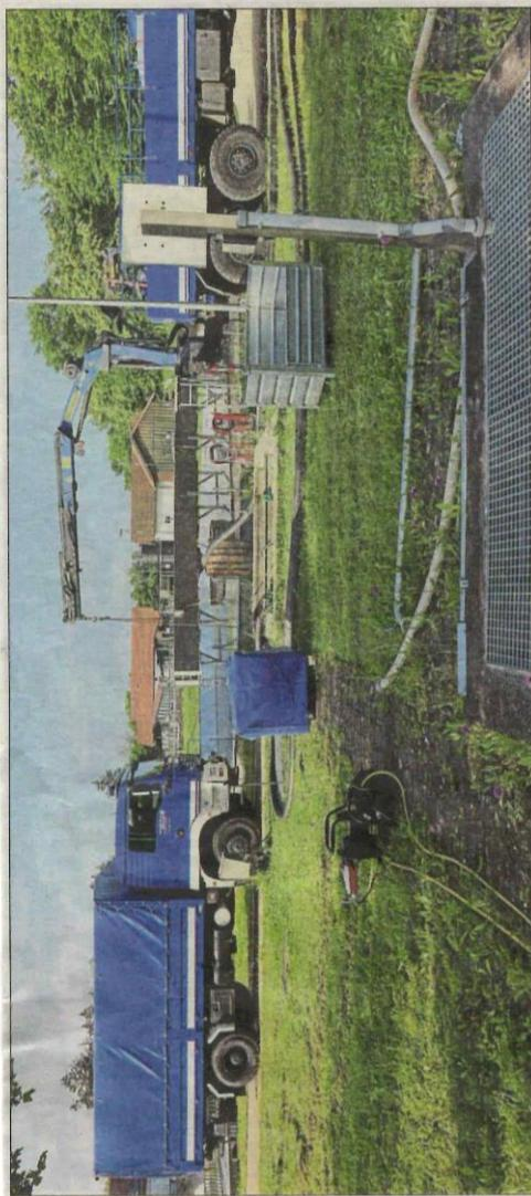
An der Moosburger Kläranlage wurde Alarm ausgelöst, als die Auffangbecken überzulaufen drohten. Der Rückstau in den Rohrleitungen war zu groß, so dass nun mit Pumpen und Schläuchen des THW das geklärte Wasser oberirdisch zur Isar gepumpt wird.
