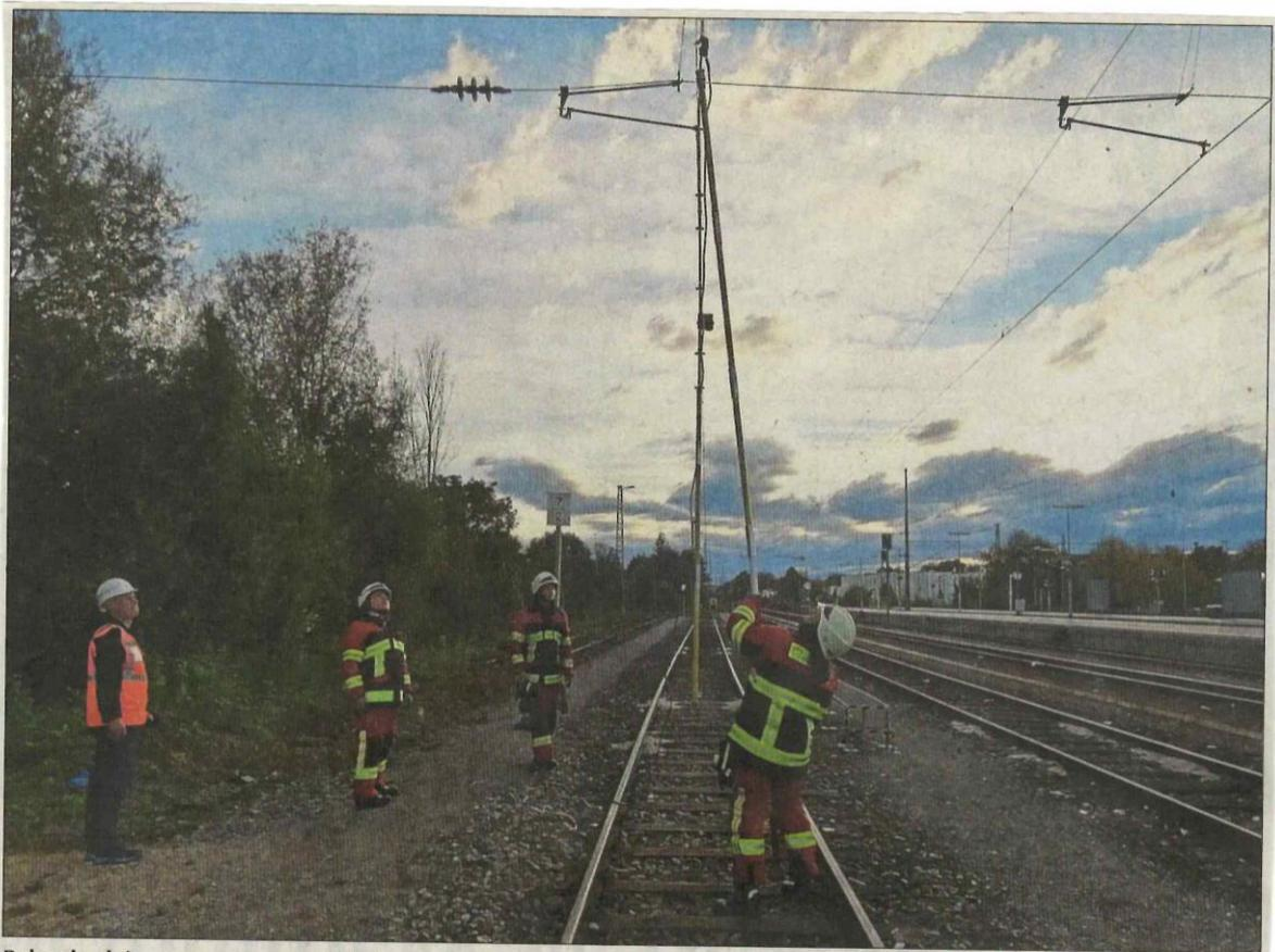
Bahnoberleitungen müssen bei Einsätzen geerdet werden, um die Sicherheit der Rettungskräfte zu gewährleisten.
