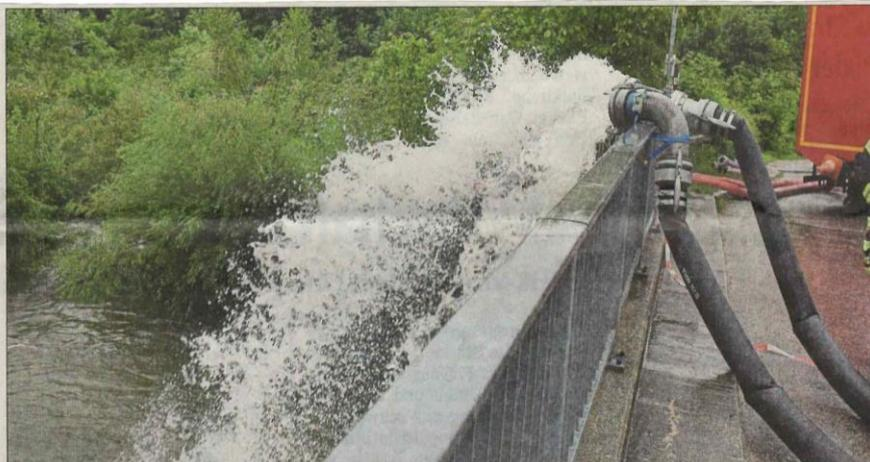
51000 Liter werden pro Minute von THW und Feuerwehr mit Hochleistungspumpen vom Amperüberleitungskanal in die Isar befördert, um die Amper zu entlasten und den Grundwasserspiegel in der Bonau stabil zu halten. Fotos: René Spanier
